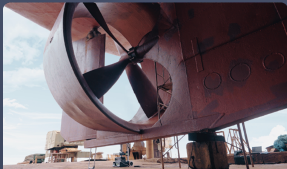
Техническое обслуживание и капитальный ремонт
